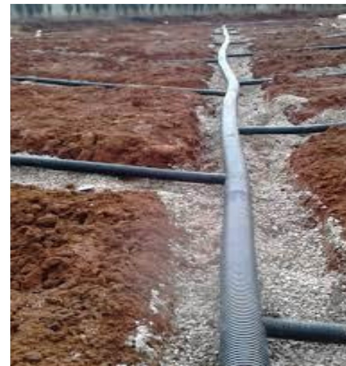
Esta foto muestra la cantidad de infraestructura de drenaje que podría existir en un campo típico de granja. El drenaje mantiene los suelos lo suficientemente secos como para que los agricultores cultiven cultivos en un suelo que de lo contrario podría estar demasiado húmedo.
